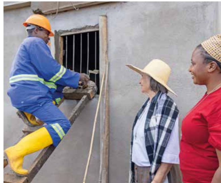
Schwester Argentina João Amisse (r.) und Schwester Leila de Souza e Silva besuchen eine Baustelle des Projekts „Häuser ja – Hütten nein“ in Metarica/Mosambik.
