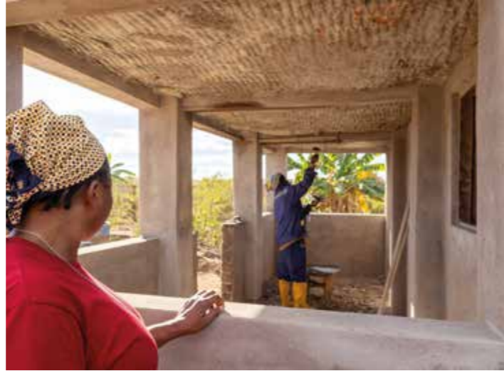
Schwester Argentina João Amisse begutachtet die Fortschritte beim Bau dieses Hauses im Rahmen des Projektes „Häuser ja – Hütten nein.“
